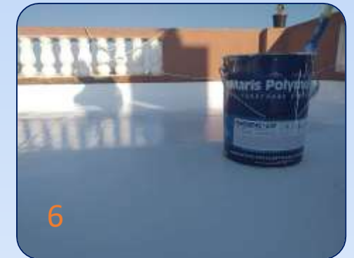
APPLICATION D'UNE COUCHE DE FINITION
