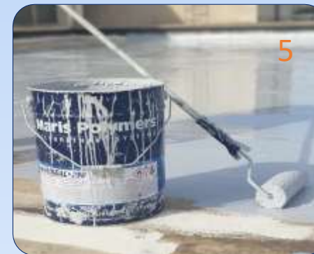
APPLICATION 2 COUCHES DE MEMBRANE PU
