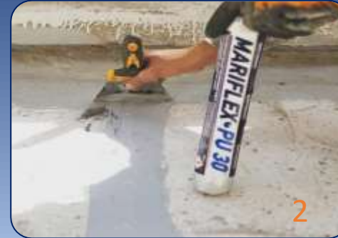
TRAITEMENT DE FISSURE AVEC MASTIC PU
